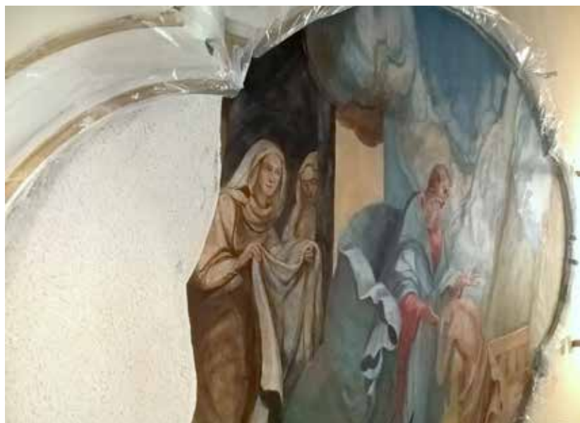
Fragment fresku Syn marnotrawny w kościele Marii Magdaleny w Tychach. Po lewej: surowa warstwa arriciato , po prawej: malowidło naniesione na warstwę intonaco | fot. archiwum prywatne
